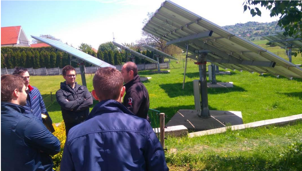
Slika 11: Oglad fotonapetostnih sledilnih sistemov na terenu
